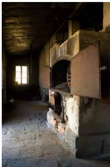
Eldstadshallen med ångpannan.
